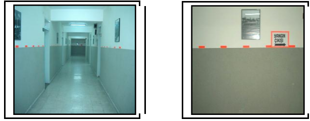
Sınırları belirlenmiş koridor örneği (Konya Görme eng. İlköğretim okulu)
