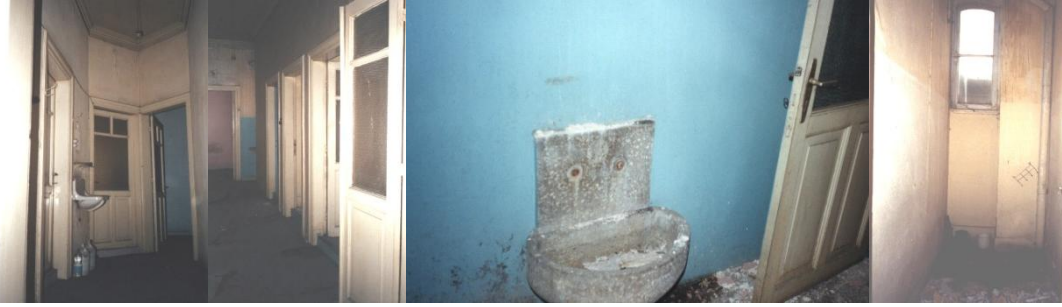
Resim 15: Koridorlar, banyo ve tuvalet görünüşü(kendi gözlemlerim, 2002)
