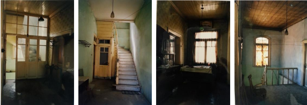
Resim 5: Yapının iç mekan görünüşleri 22.11.1989 (K.T.V.K.K.)
