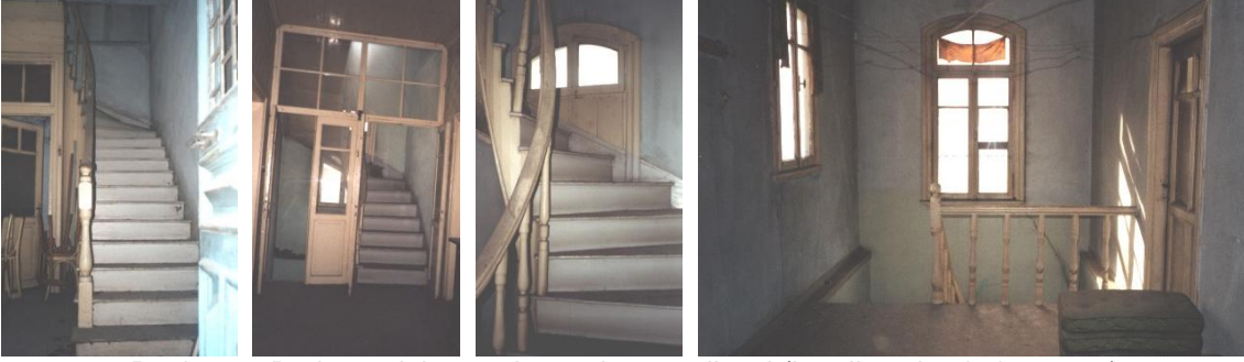
Resim 11: Bodruma iniş, üst kata çıkış merdiveni (kendi gözlemlerim, 2002)
